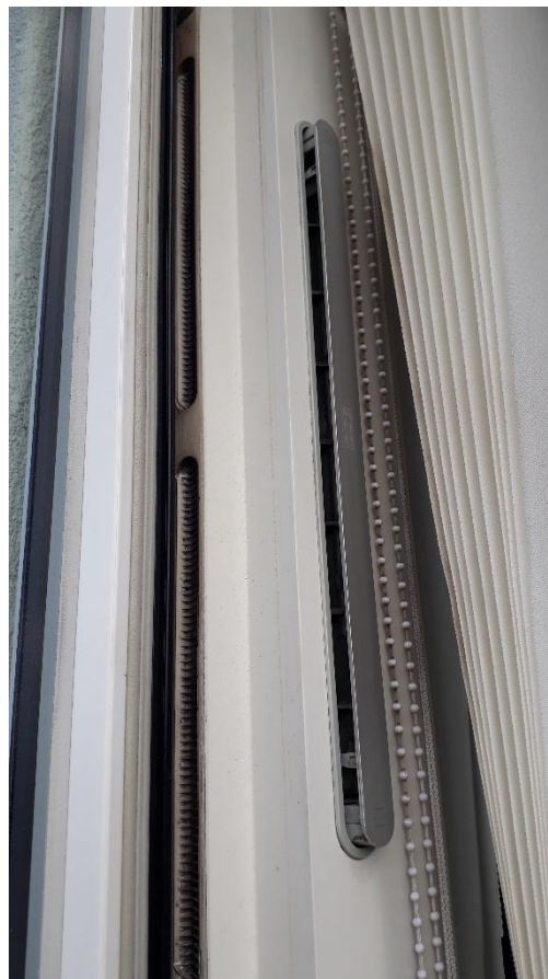
Her ses friskluftventilen til højre og de to filtre til venstre.
